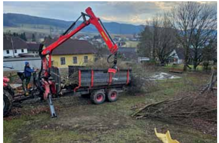
Erste Arbeiten zum Neubau des Kindergartens sind durch unsere Bauhofmitarbeiter bereits erfolgt
