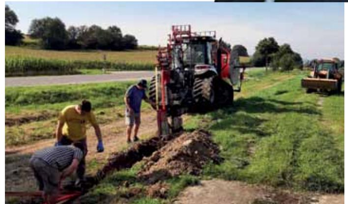
wird, wurde bereits die Glasfaserinfrastruktur mittels Pflugverlegung durch die Firma Schönhofer Bau und Berger Bagger auf der alten Bahnstrecke eingebracht. Diese Vorinvestitionen seitens der Gemeinde werden bei Realisierung des Projektes durch die nÖGIG wieder refundiert. Außerdem stehen wir auch bereits in engem Kontakt mit unseren Nachbargemeinden, wie weitere Ausbauschnitte in den nächsten Jahren aussehen könnten.
